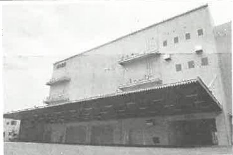
竣工式を行った福岡中央ロジスティクスセンター
